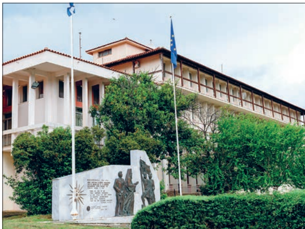
Το Διοικητήριο του Νομού Χαλκιδικής, σημερινή Περιφερειακή Ενότητα με το Μνημείο του Μακεδονικού Αγώνα
