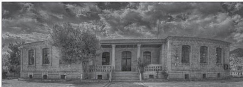
Το Δημοτικό Σχολείο Συκιάς (εμπρόσθια όψη) φωτ. Γ. Κοτρώνης
