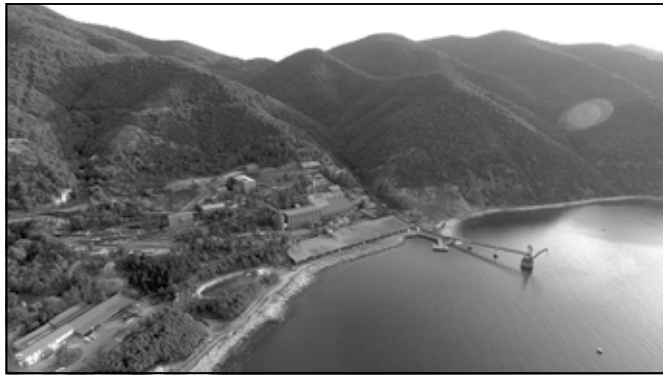
Το εργοστάσιο εμπλουτισμού μεικτών θειούχων μεταλλευμάτων στο Στρατώνι, με τις εγκαταστάσεις φόρτωσης στο λιμάνι.
